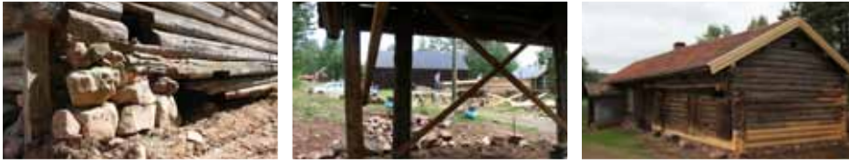
Före, under och efter restaurering av timmerstommen till en ladugård i Brunnsberg. Foto: Hans Rosdahl
